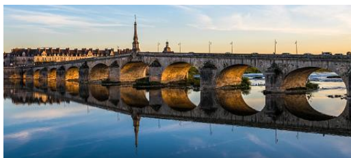
Imatge 5. Pont de Decize. Imatge extreta de:
