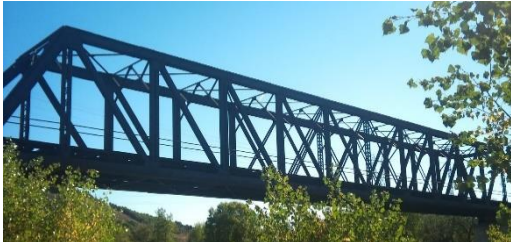
Imatge 13. Pont d'armadura Pratt.
