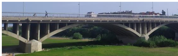
Imatge 22. Pont de Santa Coloma de Gramenet. Imatge extreta de: Font pròpia.
