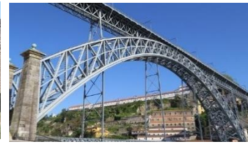
Imatge 11. Pont Don Lluís I. Imatge extreta de: https://www.oporto.es/que-ver/puente-don-luis-i/
